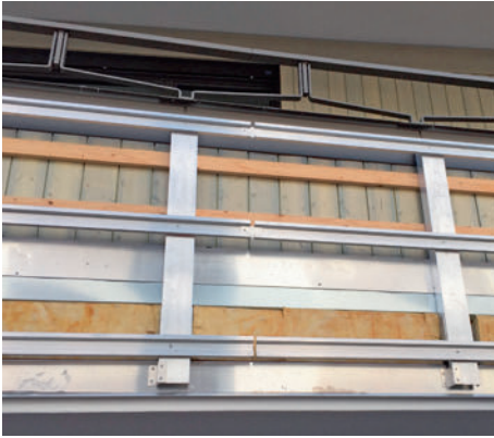
Bild 3: Offengelegte Aluminium-Tragstruktur der Brüstung. Figure 3 : Structure porteuse visible du garde-corps, en aluminium
