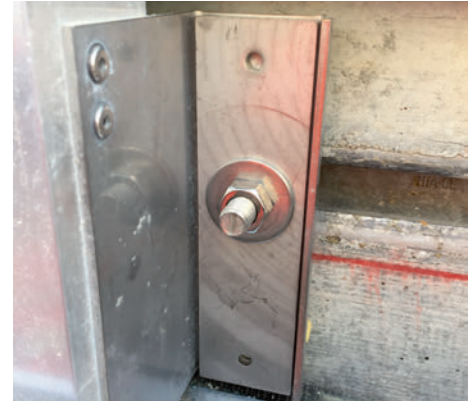
Bild 5: Eingelegte Verstärkungsplatte in Edelstahlblech 6 mm. Figure 5 : Plaque de renfort en tôle d'inox de 6 mm
