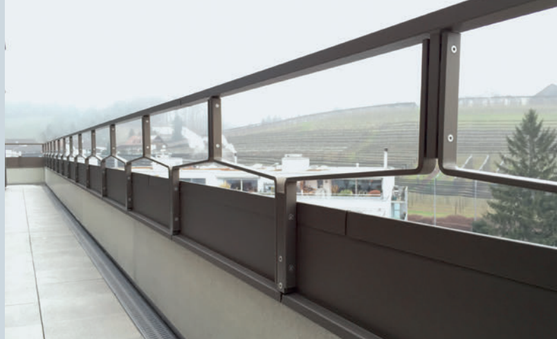
Bild 1: Ansicht Innenseite Attikageländer. Figure 1 : Vue de la balustrade de l'attique côté intérieur
